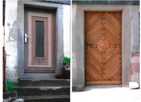
Die alte neue Tür (links) und die neue alte Tür (rechts). Denkmalgerechte Sanierungen wurden über viele Jahre vermieden.
